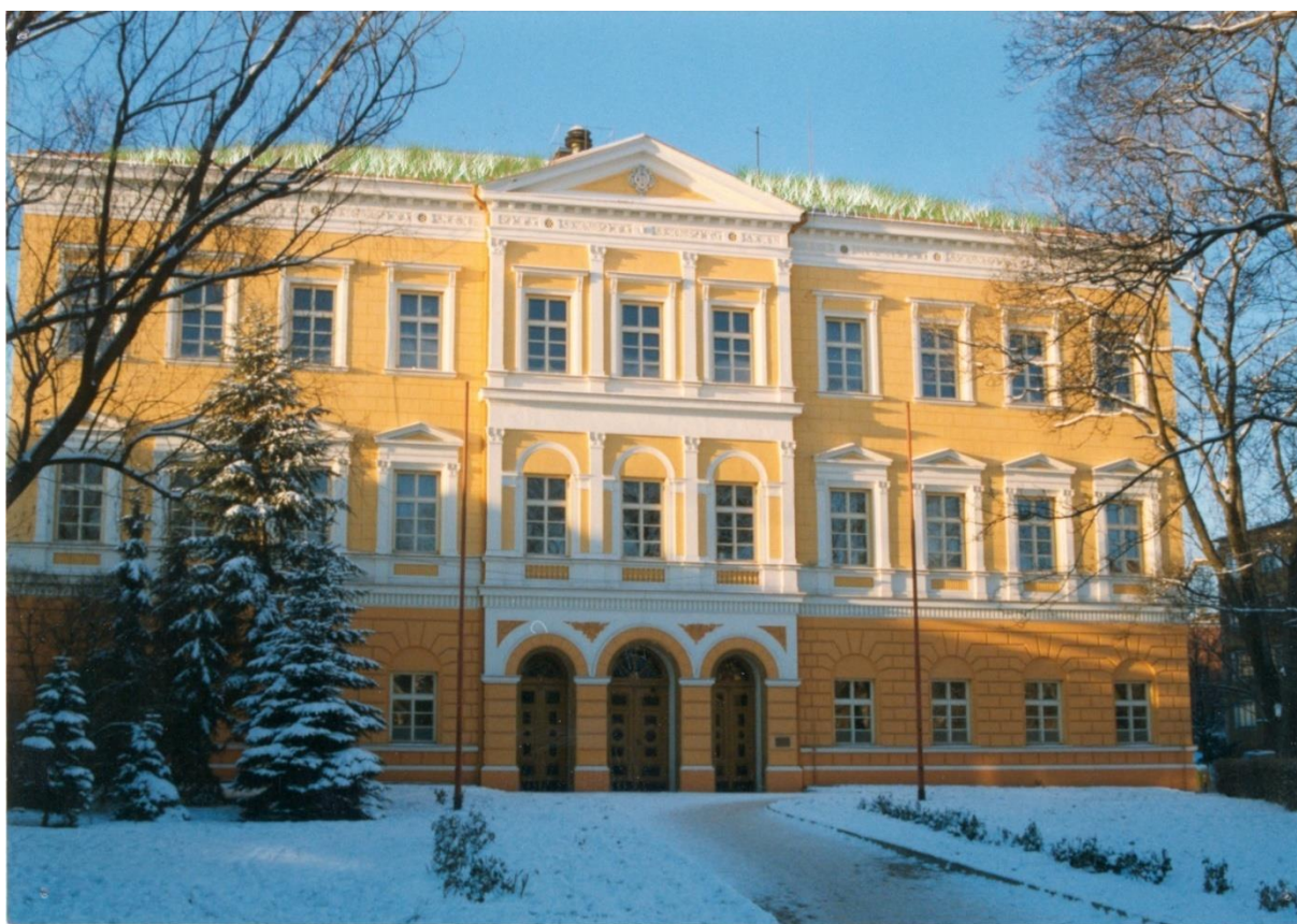
Příklad nevhodně zvolené budovy, na kterou se z estetického hlediska zelená střecha nehodí
