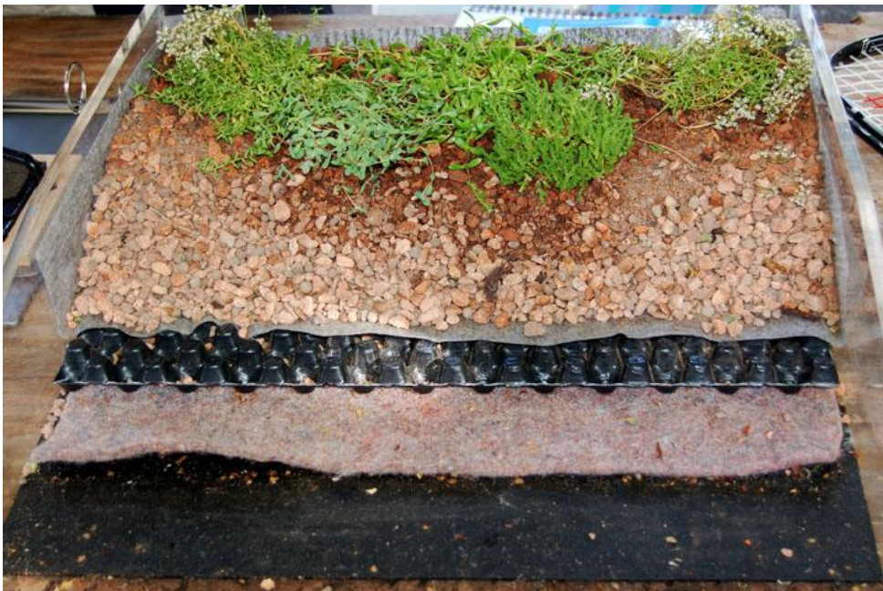
Detail a řez konstrukční skladbou zelené střechy.
